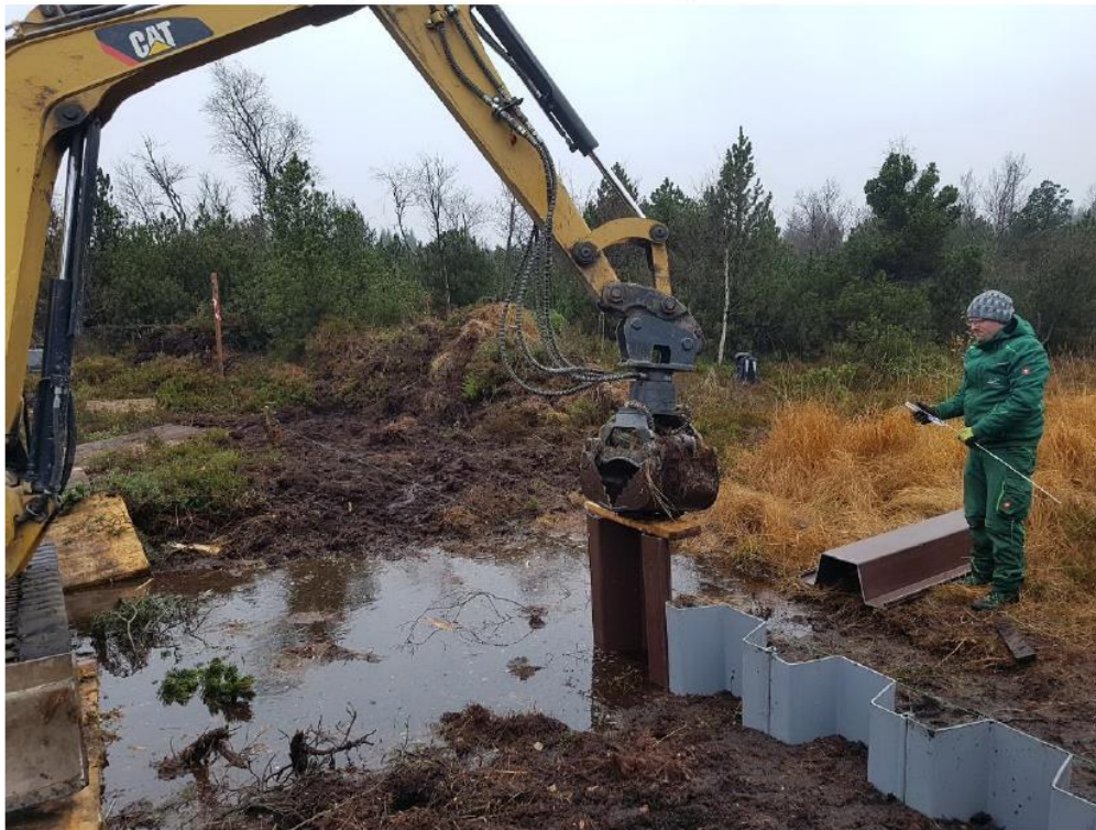
Abb. 6: Einbringen der Spundwand für Stau 1. Foto: R. Dittrich, 28.10.2020
