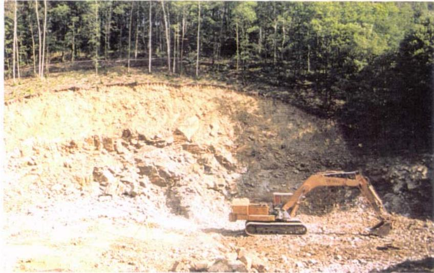
Abb. 200 Abgrabung zur Vergrößerung der Baufläche für eine Kläranlage (vgl. Beispielkartierung Testgebiet 5).
