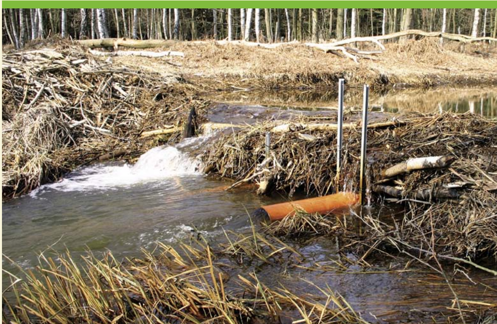
Eingebautes Drainagerohr in Biberdamm
