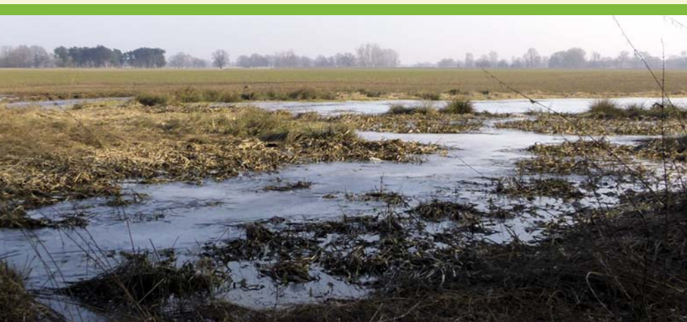
Durch einen Biberdamm verursachter Rückstau
